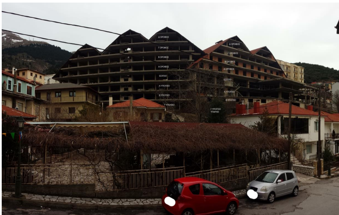
Εικόνα 2 Νότια όψη του κτηρίου
